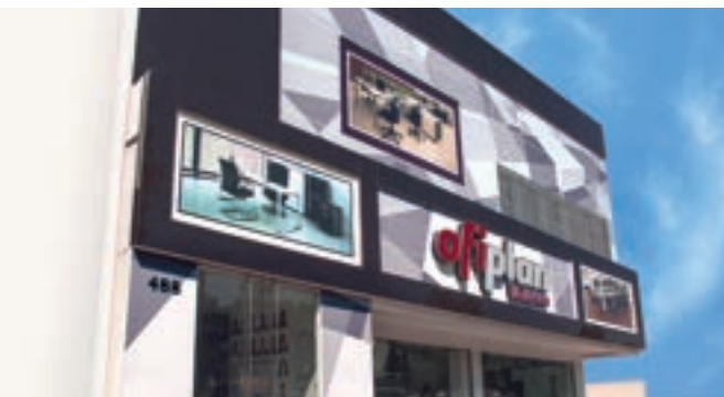
SHOWROOM CHAPULTEPEC Chapultepec Sur No. 488 entre Mexicaltzingo y Montenegro Guadalajara, Jal
